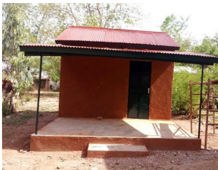
Togo Ogaro - Ferme pédagogique – Achat d'un moulin à grain et construction de son hangar
