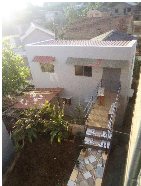
Madagascar CACERE Centre d'Appui à la Recherche d'Emploi – Construction un étage
